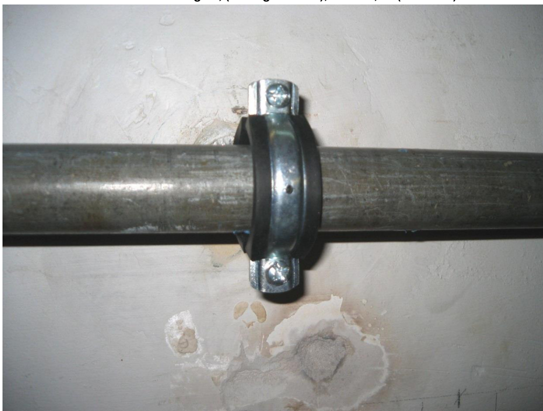
Bild 2: Schraubrohrschele DÄMMGULAST® gelb, (Kreuzgeometrie), M8/M10, 1" (32-38mm)
